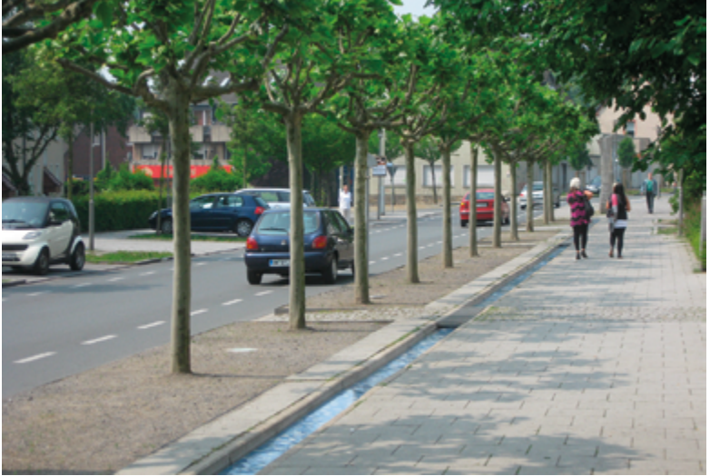
Abb. 77: Kleiner Regen- wasserkanal neben einer Straße in Bergkamen
