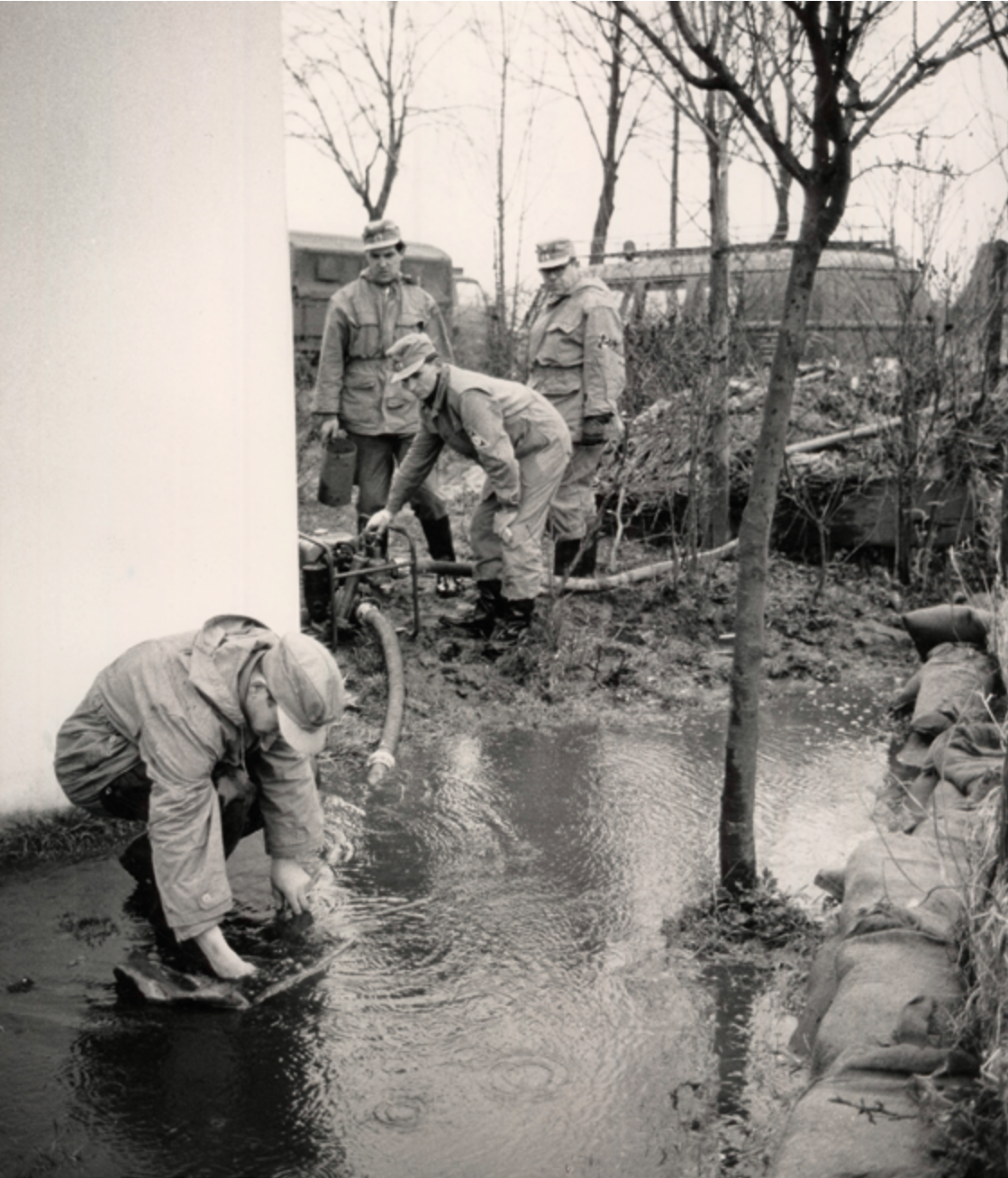
Abb. 13: Einsatz des Technischen Hilfswerks in den 1950er Jahren bei einem Hochwasser
