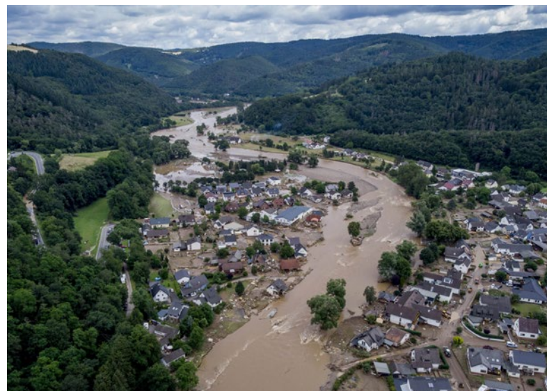
Abb. 34: Nach dem Extremwetter: Sowohl die Raum- und Siedlungsplanung als auch der Katastrophenschutz sind gefragt, um verheerende Auswirkungen von Starkregen wie im Ahrtal 2021 zu verhindern. (Quelle: Shutterstock / Vincenzo Lullo)
