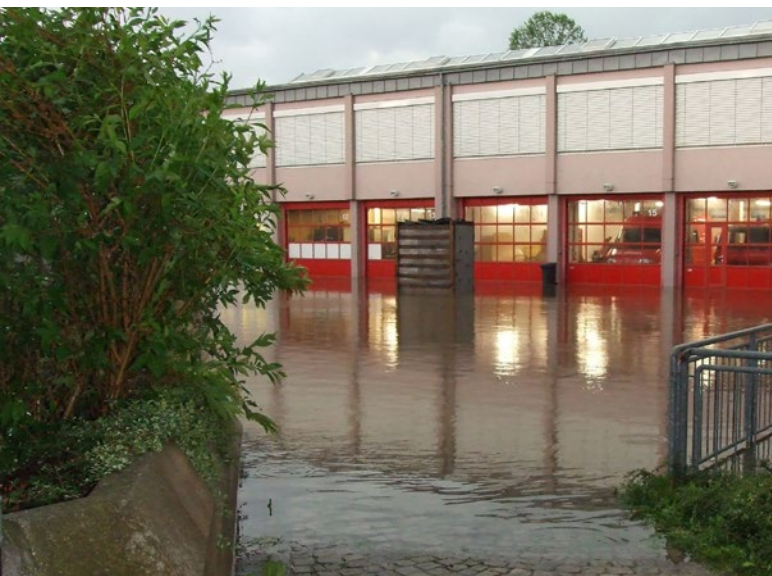
Abb. 23: Eigenbetroffenheit durch eine Überflutung der Gerätehalle (Foto: Feuerwehr Buchen)
