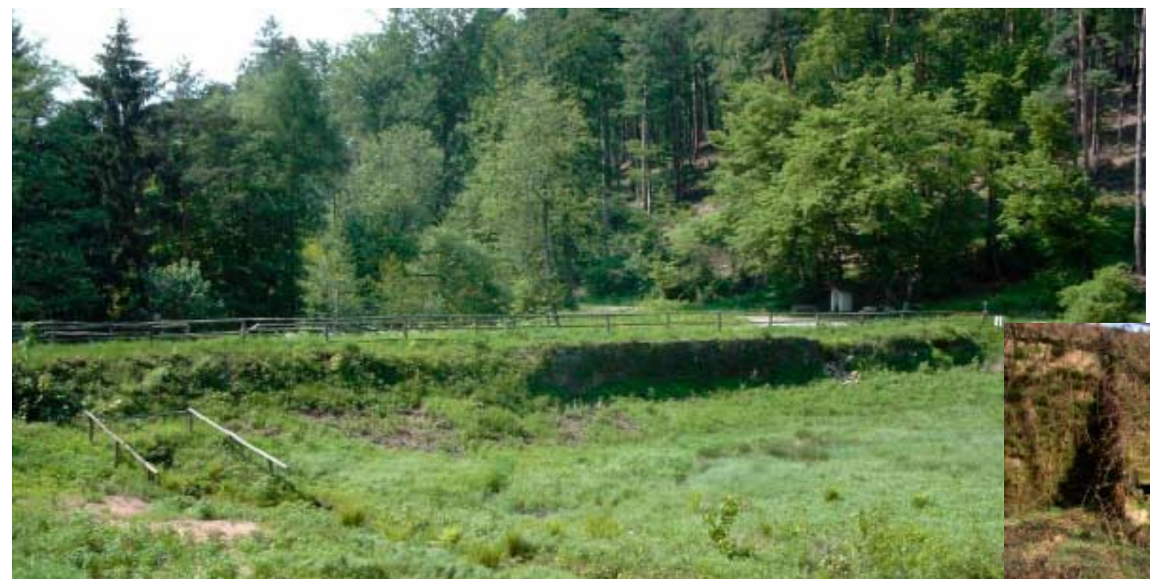
Der obere der beiden Triftdämme heute; rechts die Öffnung für den raschen Abfluss des gestauten Wassers.
