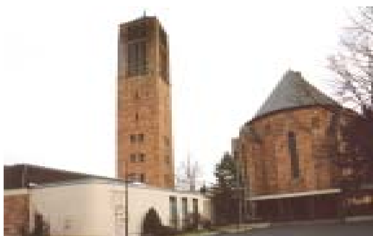
Teile der Rosenkranzkirche in Stockstadt wurden mit Buntsandstein aus dem Steinbruch Keiner in Oberbessenbach erbaut.
